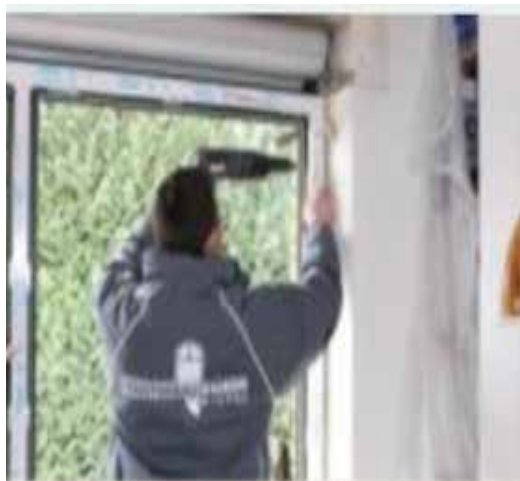
Слика 12 Центрирање и механичко причвршћивање столарије
