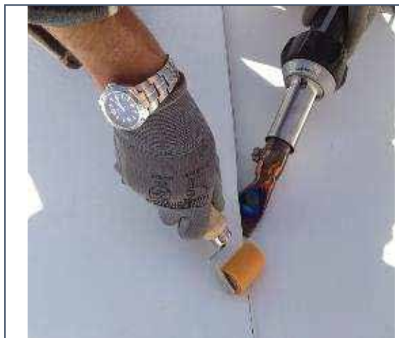
Слика 170 Заваривање хидроизолационог слоја са врућим ваздухом
