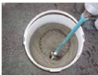
Слика 64 Мијешање малтера за арматурни слој
