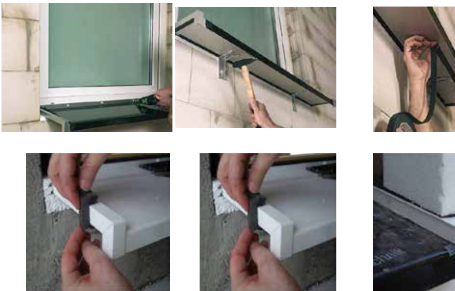
Слика 82 Заптивање прозорске клупице
