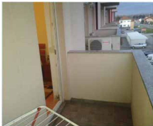
Слика 196 Примјер топлотног моста код балкона
