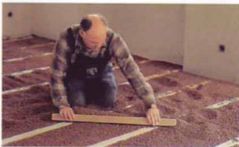
Слика 145 Једноставно поравнање између дрвених елемената стропа
