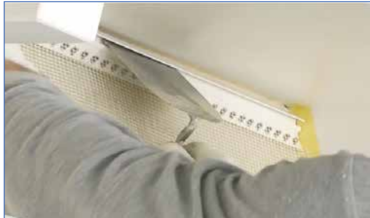
Слика 90 Уградња атика-профила за спој ETICS-а са невентилисаним косим кровом
