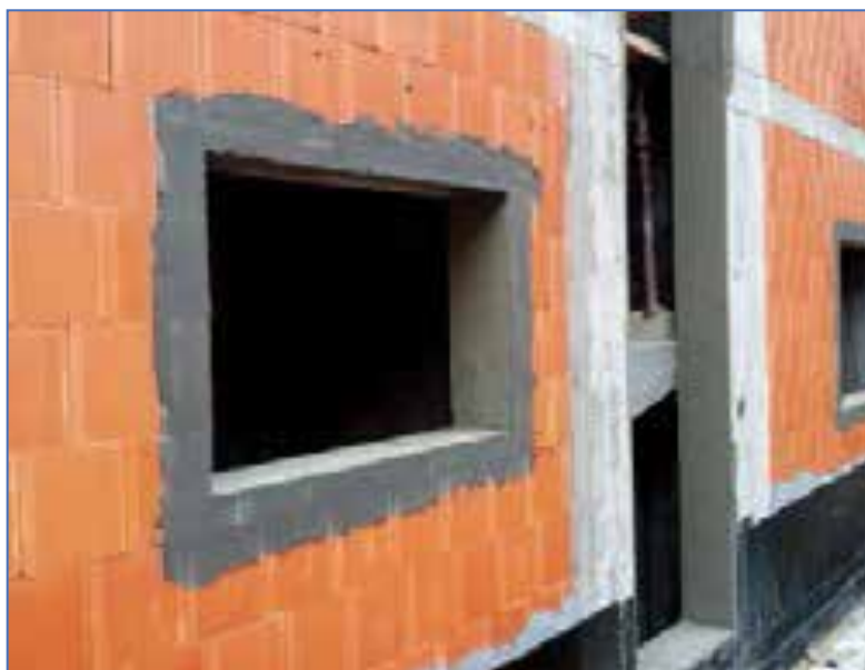
Слика 11 Правилно припремљен отвор за уградњу прозора
