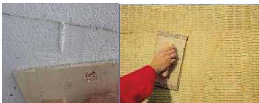
Слика 49 Брушење EPS и MW плоча
