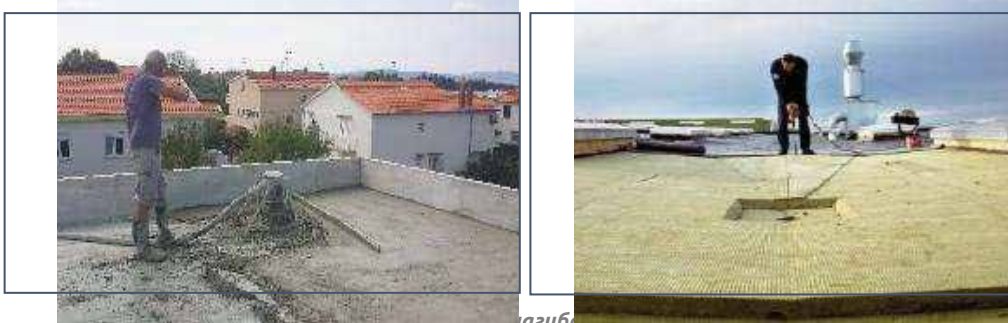
Слика 167 Извођење нагиба равне крова
