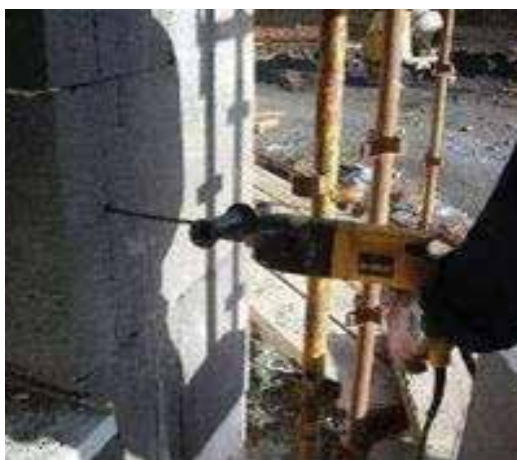
Слика 50 Бушење рупа за типлове
