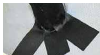
Слика 149 Правилно извођење продора кроз паропропусно-водонепропусну фолију
