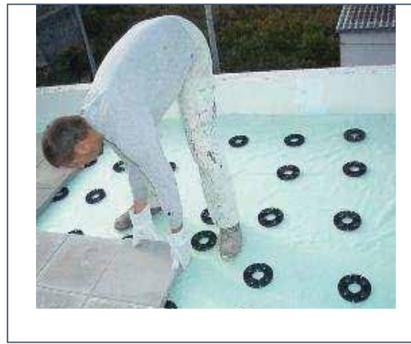
Слика 172 Заштита хидроизолације
