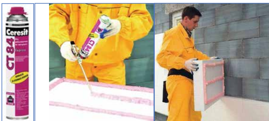
Слика 44 Наношење PUR љепила на EPS плоче
