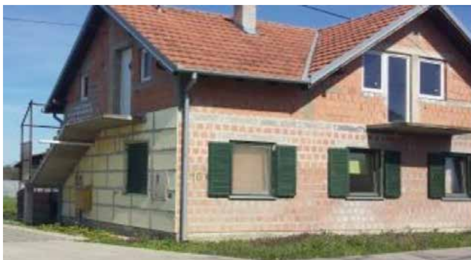
Слика 138 Неправилно постављање топлотноизолационих плоча
