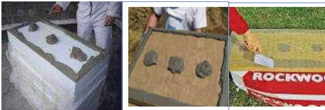
Слика 40 Тачкасто наношење љепила на EPS плоче, MW плоче и MW ламеле
