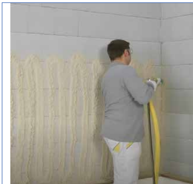
Слика 43 Машинско наношење малтера на равну подлогу
