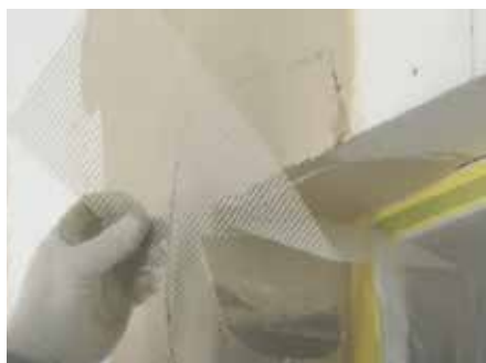
Слика 66 Схеме постављања арматурних мрежица око углова отвора, прозора и врата
