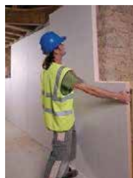
Слика 182 Специјалне топлотноизолационе плоче са интегрисаним завршним слојем
