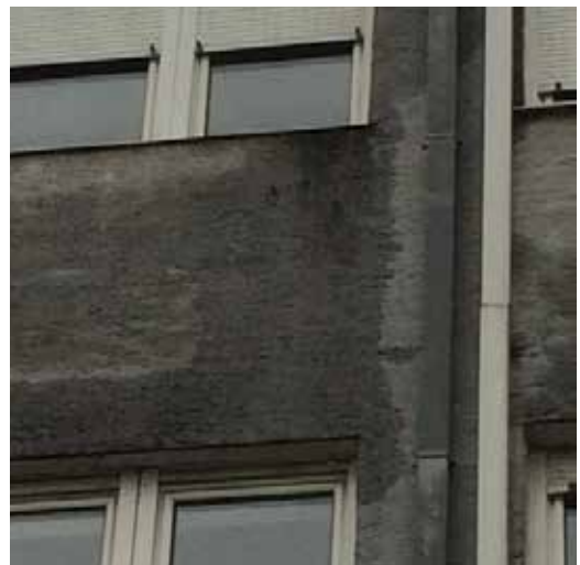
Слика 140 Неправилно изведена тераса и зона прскања (лијево) и неправилна уградња прозора (десно)
