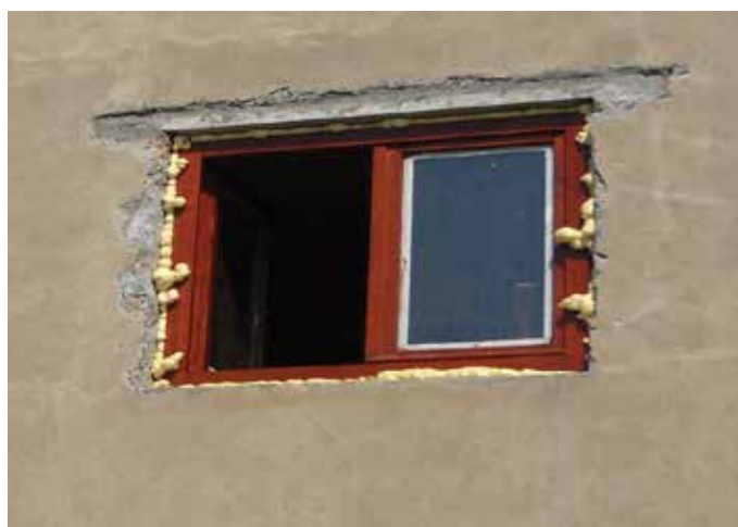
Слика 3 Типичан примјер лоше уграђеног прозора
