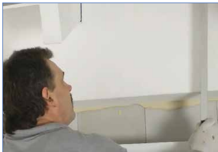
Слика 89 Поравнавање завршног реда топлотноизолационих плоча
