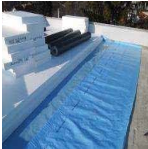
Слика 169 Парна брана од битуменске траке (лијево) и панел брана од РЕ фолије
