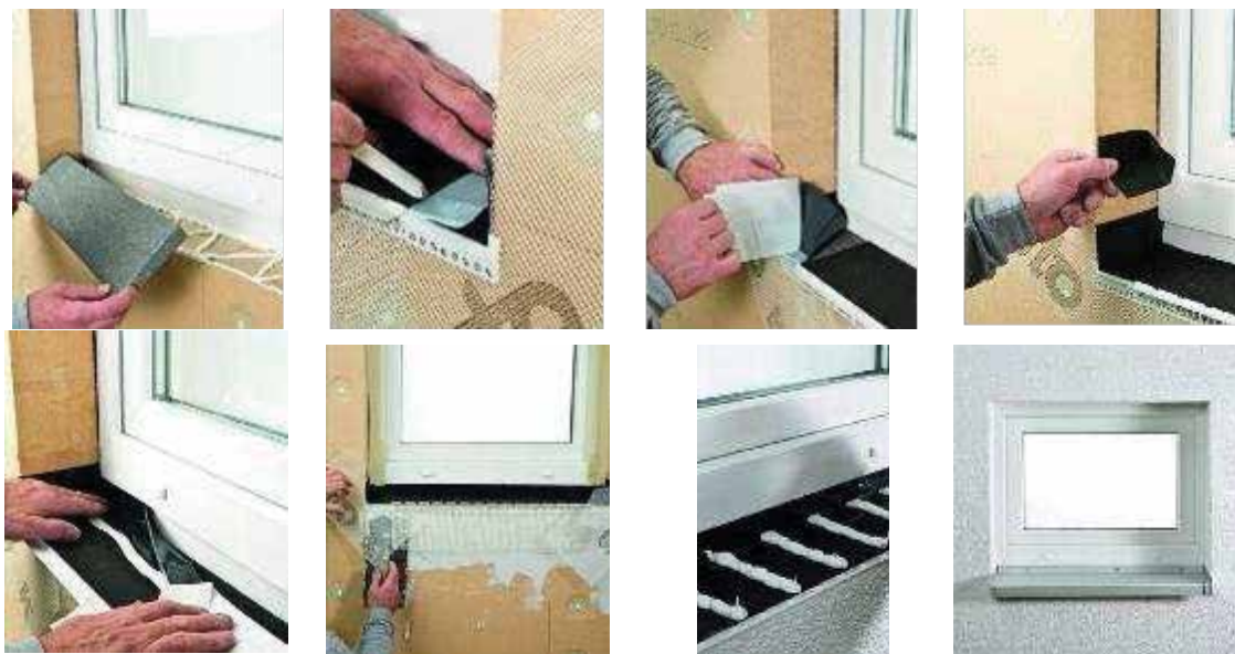
Слика 80 Кораки при уградњи прозорских клупица
