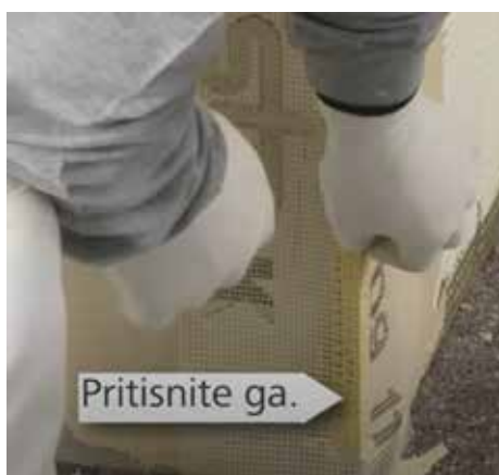
Слика 73 Постављање ивичног профила са арматурном мрежицом
