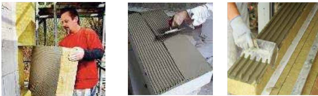
Слика 41 Наношење љепила потпуним покривањем на EPS плоче, MW плоче и MW ламеле
