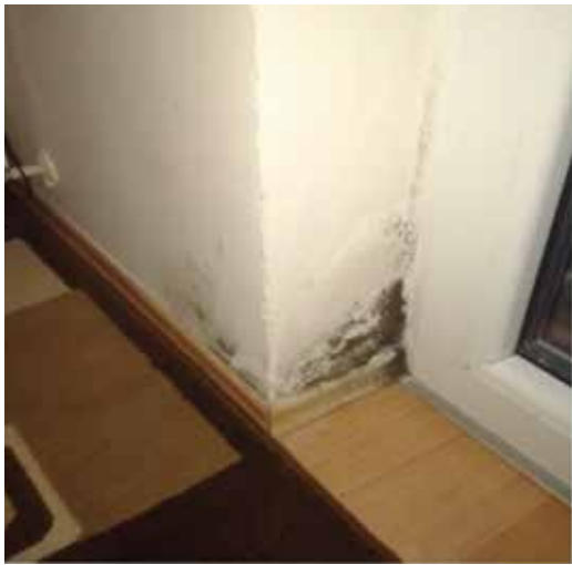
Слика 196 Примјер топлотног моста код балкона
