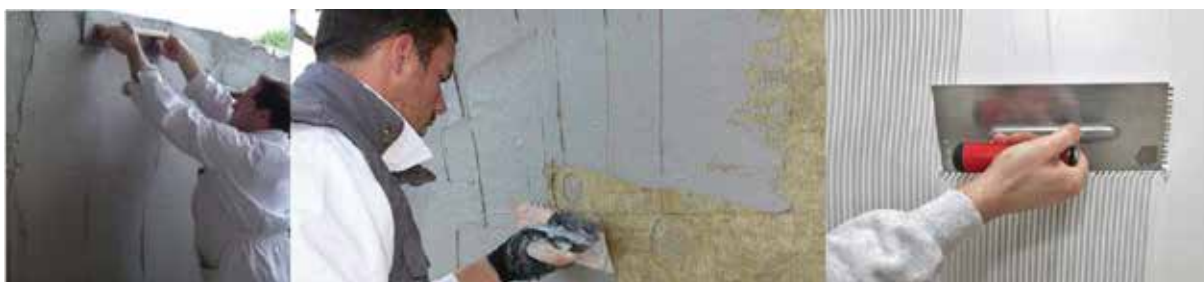
Слика 65 Наношење малтера на арматурни слој и постављање арматурне мрежице
