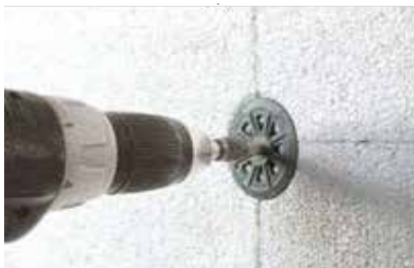
Слика 58 Постављање типла на изолацију
