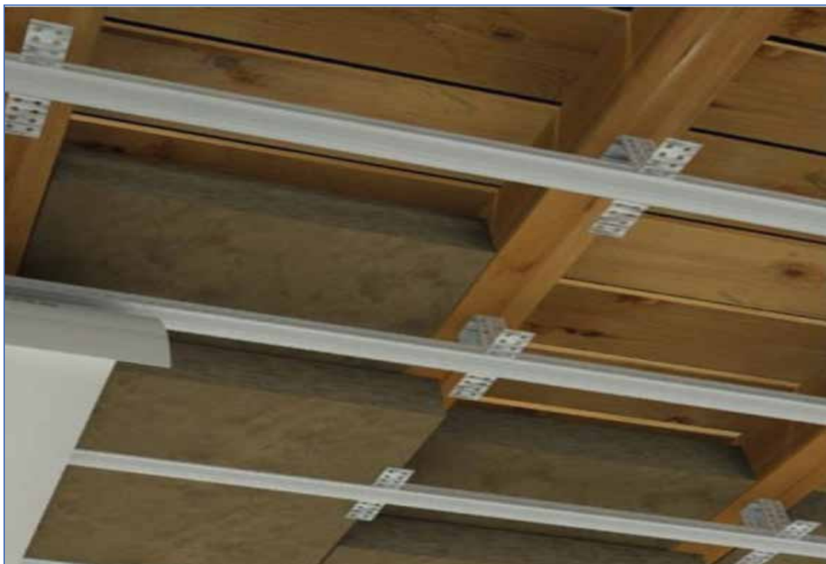
Слика 154 Коси кров са топлотном изолацијом између и испод рогова и са секундарним покровом од размакнутих дрвених елемената преко рогова
