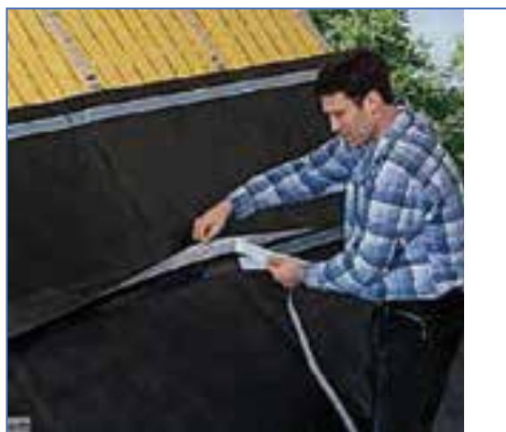
Слика 148 Постављање паропропусно-водонепропусне фолије
