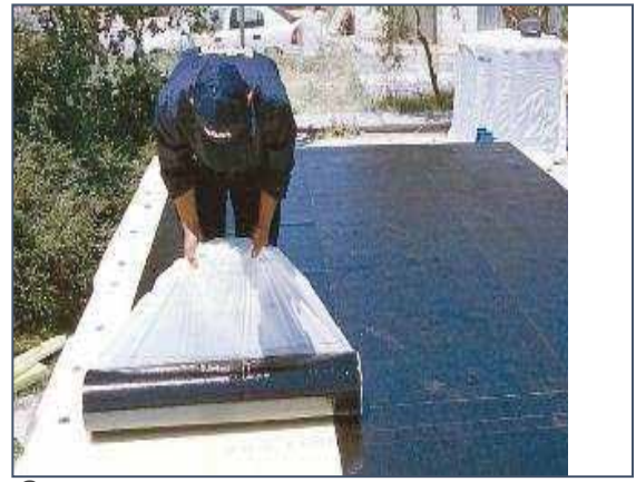
Слика 171 Лијепљење битуменских хидроизолације
