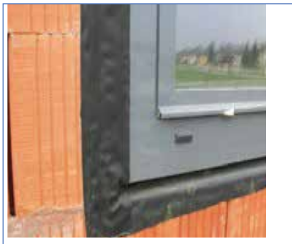
Слика 16 Изглед залијепљене парапропусно-водонепропусне фолије са вањске стране
