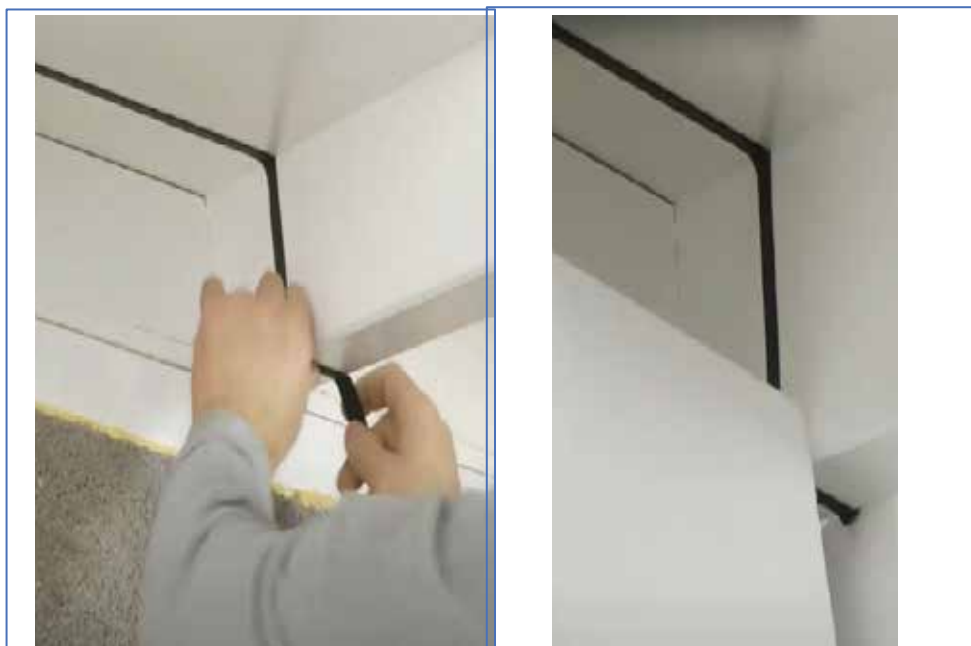
Слика 88 Постављање вањских бртвених трака
