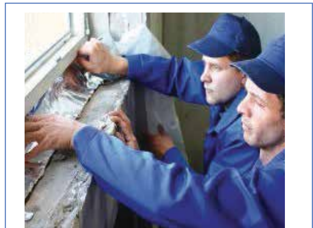
Слика 15 Постављање вањске паронепропусне и водонепропусне фолије
