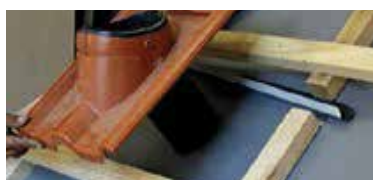
Слика 149 Правилно извођење продора кроз паропропусно-водонепропусну фолију
