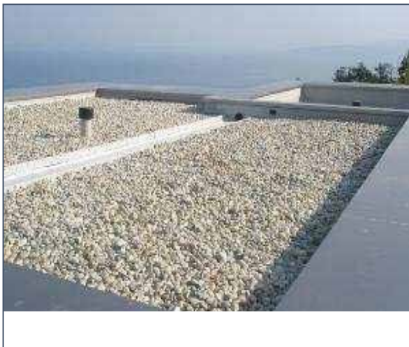
Слика 172 Заштита хидроизолације
