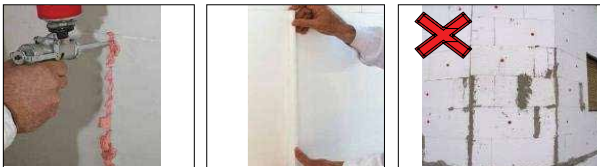
Слика 46 Испуњавање фуга између топлотноизолационих плоча PUR пјеном (лијево), истим материјалом (у средини) и примјер како не треба да се ради (десно)
