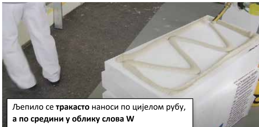
Слика 42 Машинско наношење љепила по W-схеми
