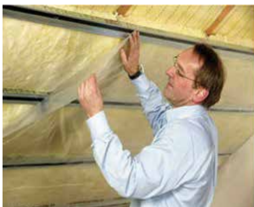
Слика 151 Постављање и лијепљење парне бране
