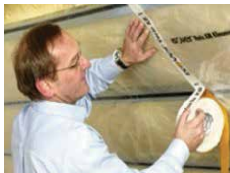
Слика 151 Постављање и лијепљење парне бране
