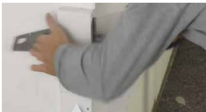
Слика 72 Одсијецање вишка топлотноизолационих плоча на угловима
