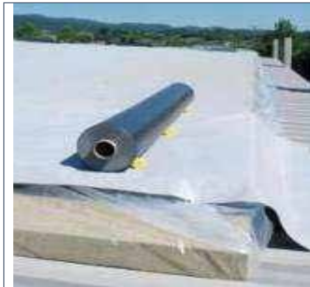
Слика 168 Слој за изједначење на равном крову
