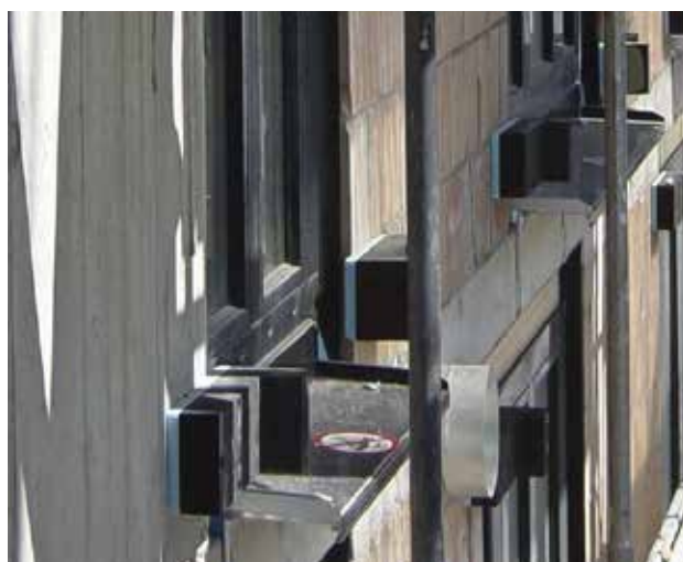
Слика 107 Прикључивање додатних елемената на ETICS системе
