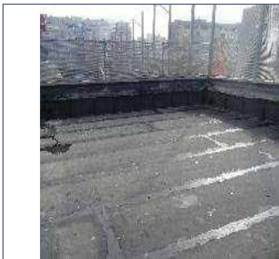
Слика 169 Парна брана од битуменске траке (лијево) и панел брана од РЕ фолије
