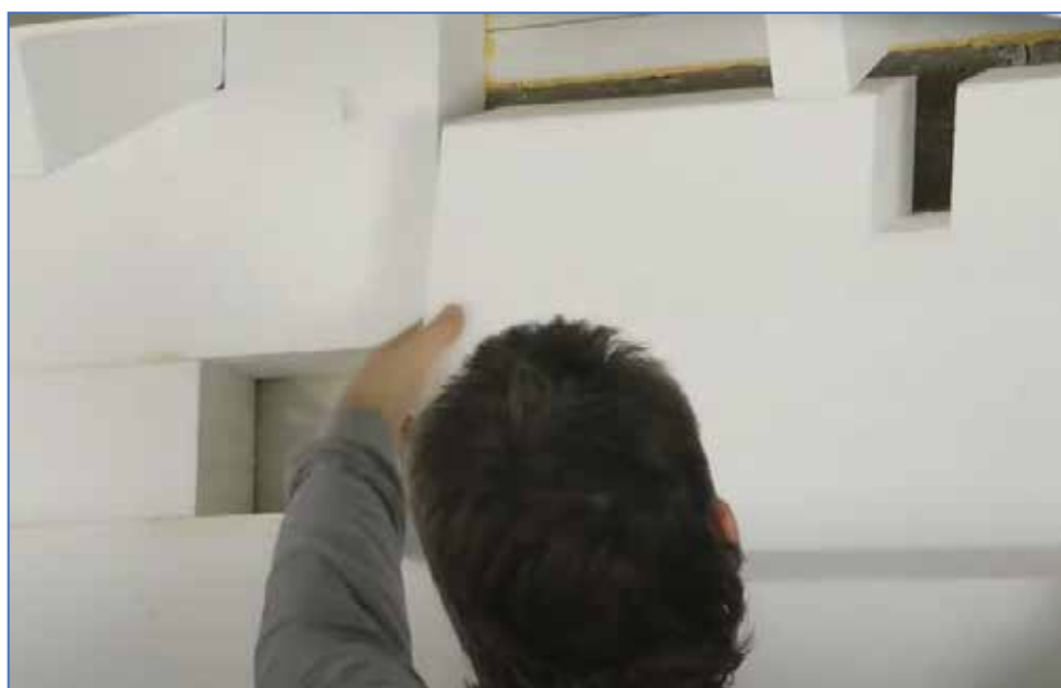
Слика 87 Уклапање завршног реда топлотноизолационих плоча са кровом
