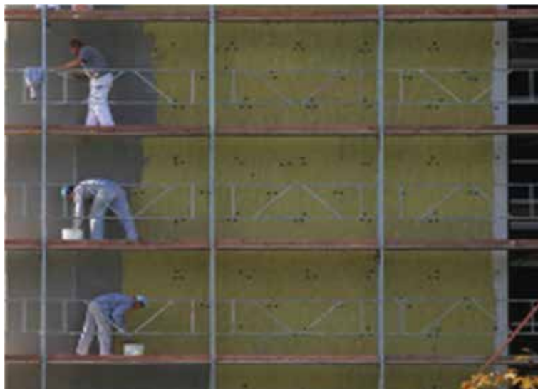
Слика 45 Постављање топлотноизолационих плоча
