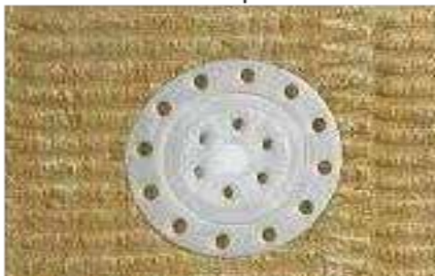
Слика 59 Постављање типлова са додатним тањиром 9 ст за MW-плоче
