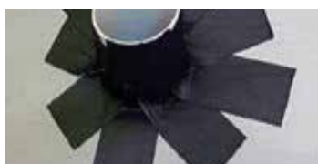
Слика 149 Правилно извођење продора кроз паропропусно-водонепропусну фолију
