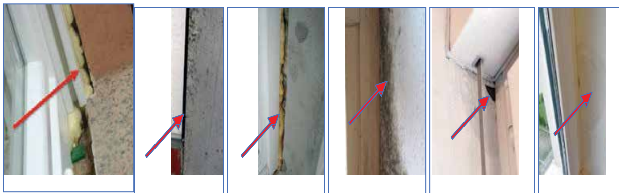
Слика 5 Појаве гљивица и плјесни насталих као посљедица лоше уградње столарије
