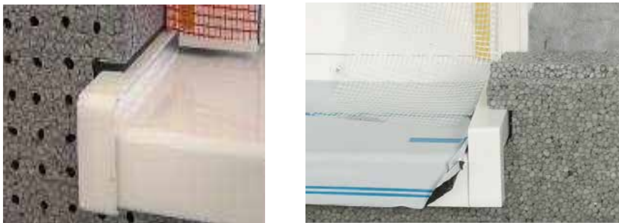
Слика 83 Спој прозорске клупице и ETICS-а
