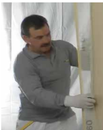
Слика 73 Постављање ивичног профила са арматурном мрежицом
