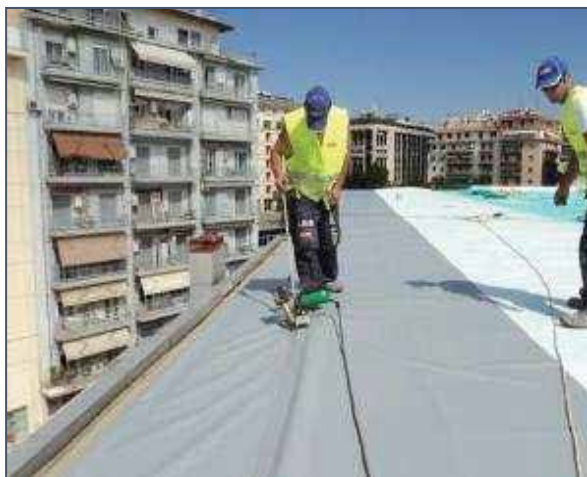
Слика 170 Заваривање хидроизолационог слоја са врућим ваздухом
